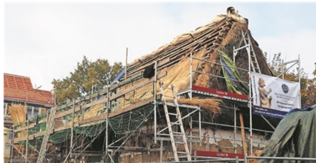
Die Arbeiten an der Scheune kommen voran. Das Gebäude steht an der Harburger Straße und ist umgeben von Neubauten. Fotos Klempow
